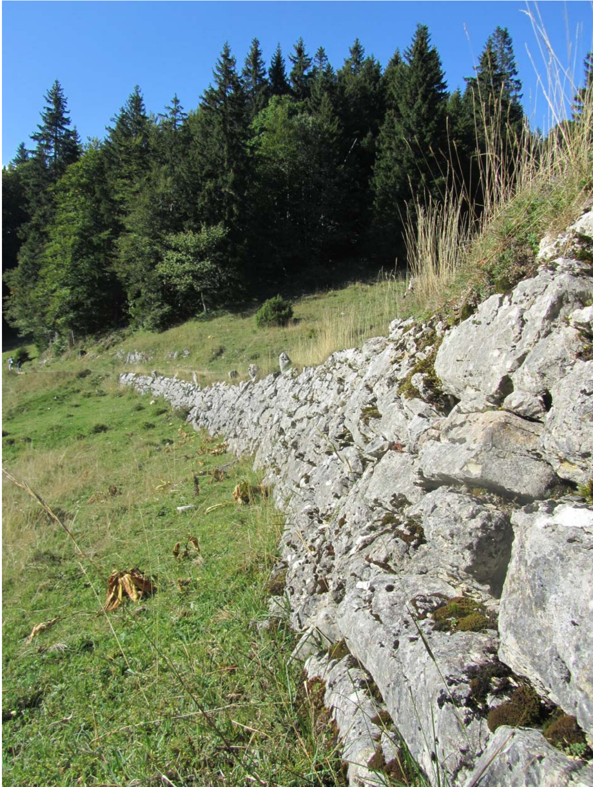
L'un des murs de soutènement du chemin conduisant de la Petite Dent Dessous à la Petite Dent Dessus.
