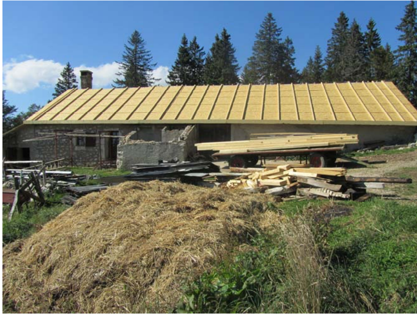
Réfection du toit 2012.
