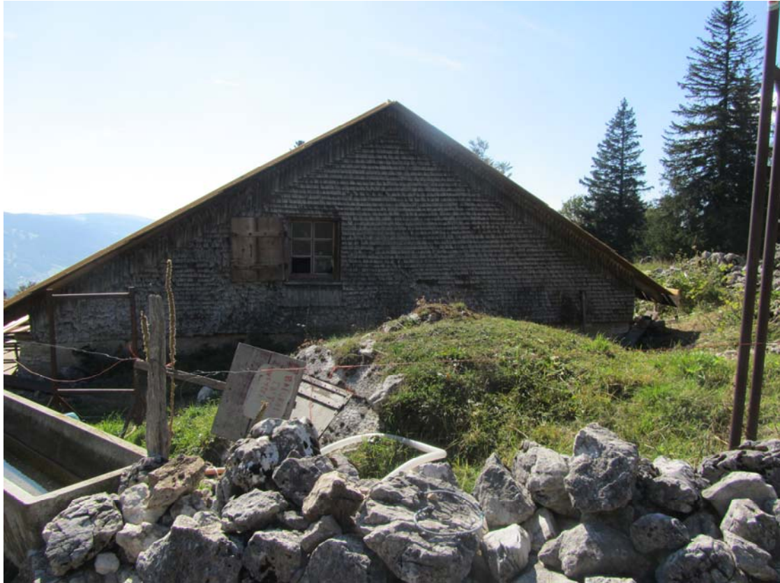
La façade côté mont garde encore les tavillons.
